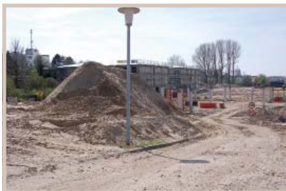
Baustelle Warringsgelände - Foto: U. Müller
