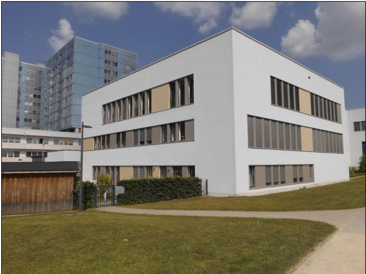
Foto: Die Kita in der Karl-Lübben-Straße verfügt über eine Dependance im Klinikum Bremerhaven.
