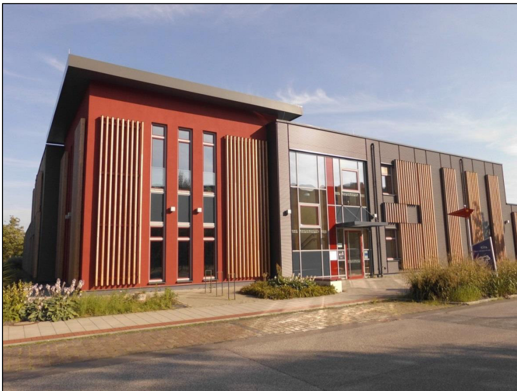
Foto: Unter einem Dach: Kita und Familienzentrum in der Folkert-Potrykus-Straße
