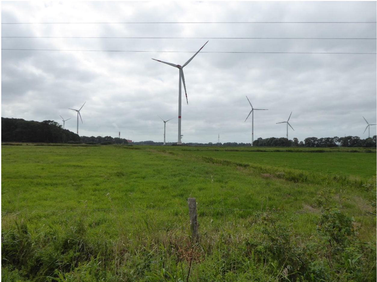
Abbildung 9 : Blick von der Gemeindegrenze auf die Geesteniederung mit den sieben Anlagen, im Hintergrund Müllverbrennungsanlage, Vordergrund: Freileitung
