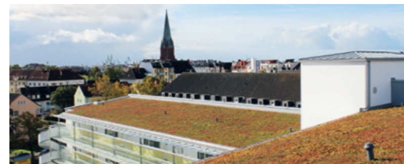
Das Stäwog-Gebäude in der Nürnberger Straße ist ein gutes Beispiel für eine gelungene Dachbegrünung
