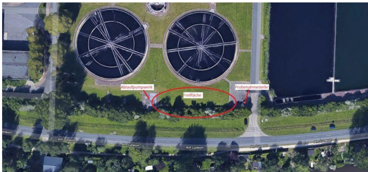
Abbildung 4-16: Position des Ablaufpumpwerks und einer Freifläche
