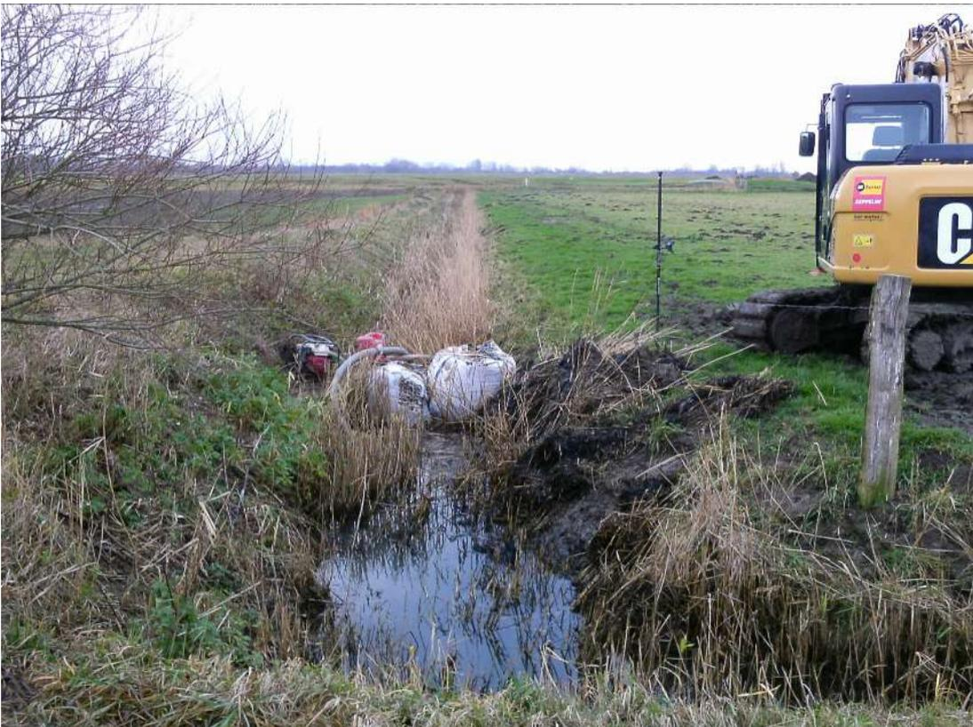
Foto 16: Abschottung Graben mit Sandsäcken zur Bergung von Anomalien
